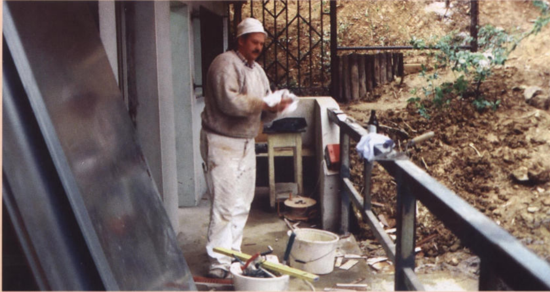
Richard Knieps verlegt die Fliesen.
