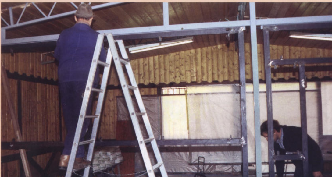
Hier sehen wir Ehrenmitglied Paul Dresen mit seinem Sohn Wolfgang, wie sie das Stahlgestänge für die Trennwände verschweissen.
